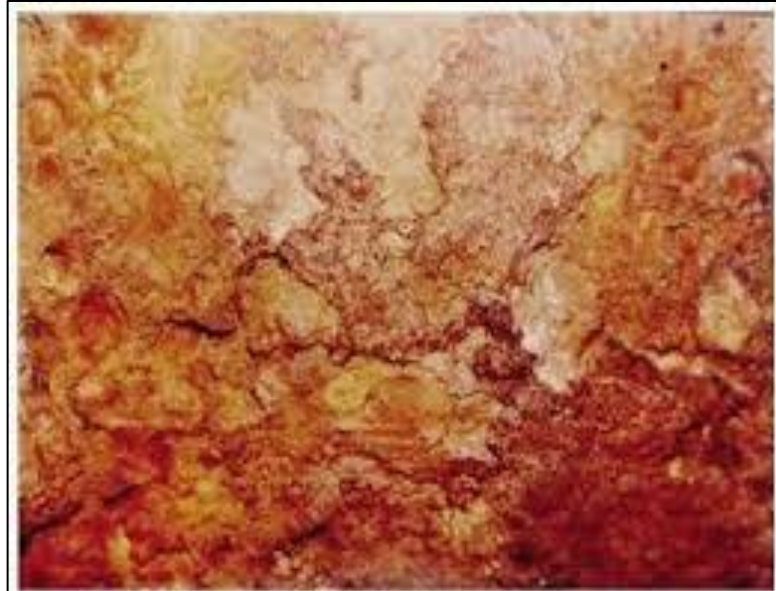
Figura 2 – Corrosão uniforme em uma chapa metálica
